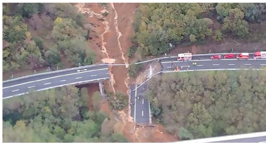
Crollo del viadotto sull'A6 Torino-Savona Effondrement du viaduc sur l'A6 Turin-Savona
