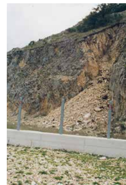
Flusso di detrito (debris flow) in calcari fratturati.
