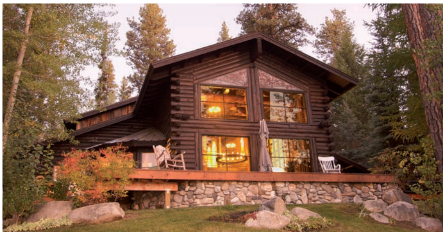
Particolare di una casa in block house.
